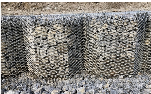
施工3日目 蓋材の設置～完成
