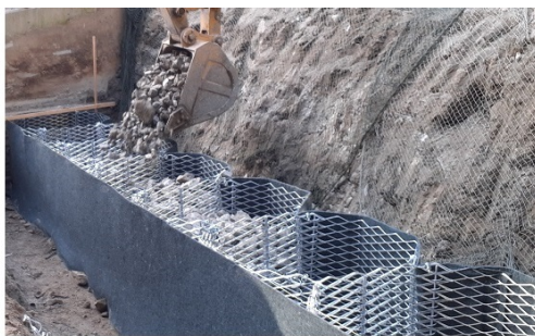
施工初日 セルの組立て～1段目の中詰投入
