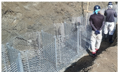
施工初日 セルの組立て～1段目の中詰投入
