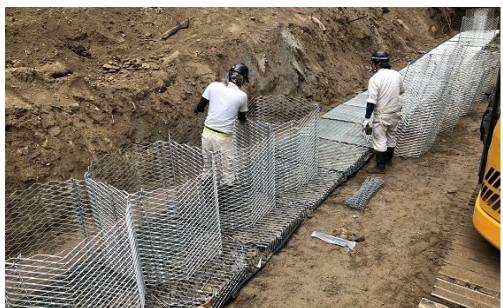
施工2日目 1段目の埋戻し～2段目の組立て・設置
