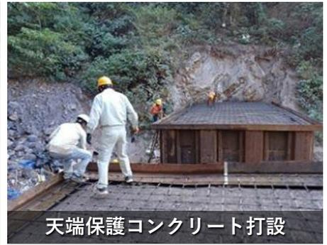
天端保護コンクリート打設
