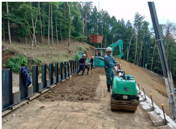
壁面際も振動ローラーによる確実な締固めが可能。 < 堤体端部強度の重要性 >
