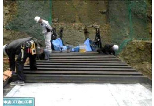
ダブルウォールは、多段タイ材と上下流壁面材によって外部から拘束補強して堤体を一体化した構造物で、災害等の緊急工事をはじめ砂防・治山分野で多く採用されている工法です。現地発生土を堤体の中詰材に有効活用できるため、コスト縮減、工期短縮が図れます。また、シンプルな構造で鋼材は無塗装のため、時間の経過とともに一様に鉄本来の茶色に変化することから、構造物が周辺環境に調和しているとのお声をいただいております。
