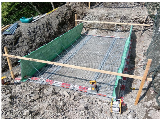
部材が軽量でボルト接合がなく組立て・設置が容易
