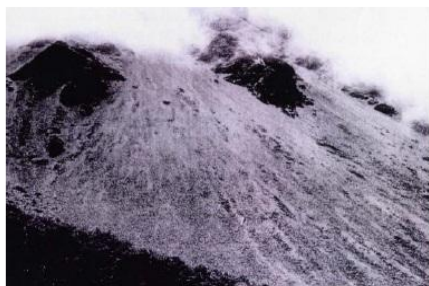
施工前（昭和11年）
