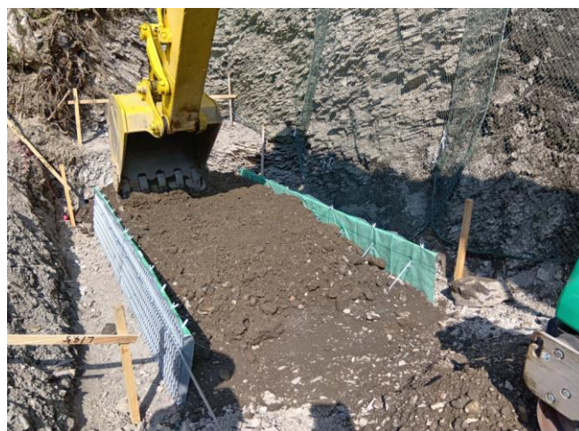
中詰材に使用現地発生土を有効利用
