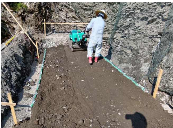
隔壁がない構造のため連続して敷均し、機械転圧によりしっかり締固めできる
