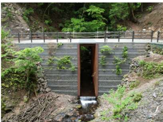
エキスパンドメタルユニットを使用し緑化した下流面
