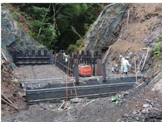
スリット両壁面の鋼矢板面アンカーウォール補強土
