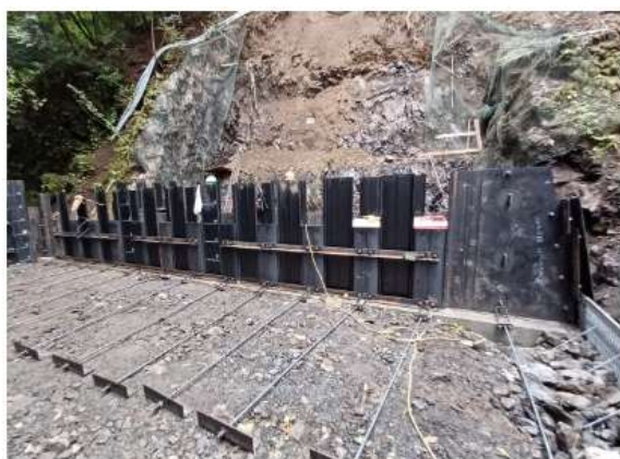
スリット両壁面の鋼矢板面アンカーウォール補強土
