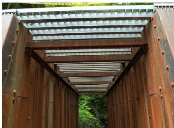
開渠上部の道路面のグレーチング
