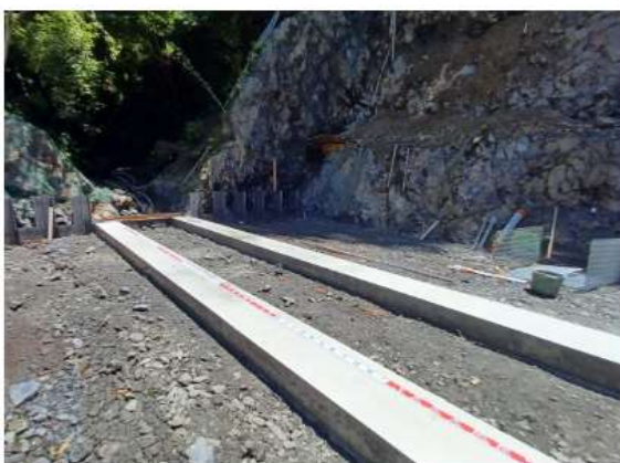
基礎コンクリートを兼ねた土砂止め
