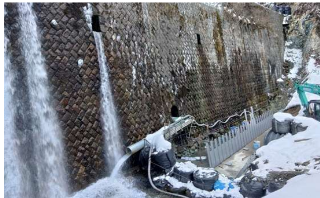
< 施工中の状況 >
