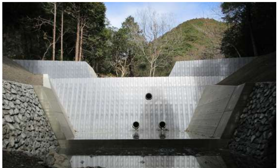
< 施工後の状況 >
