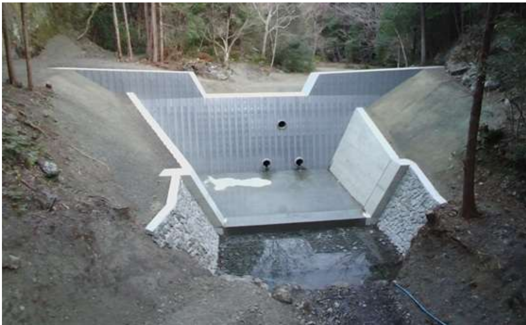
< 施工後の状況 >
