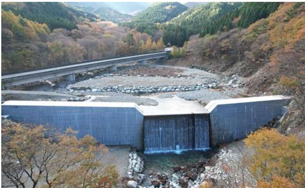
< 施工後の状況 >
