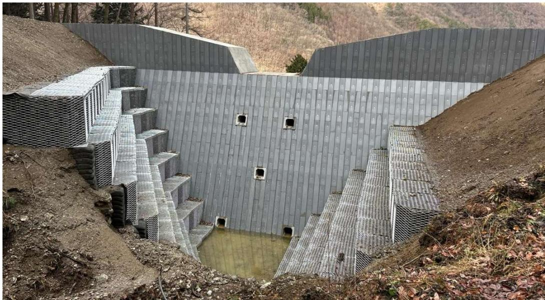
砂防堰堤の附帯施設である護岸工、流路工及び管理用道路等の土留め・擁壁工等にKYOSEIの擁壁商品群が活用された事例をご紹介します。経済性と施工性の良さが評価されています。
