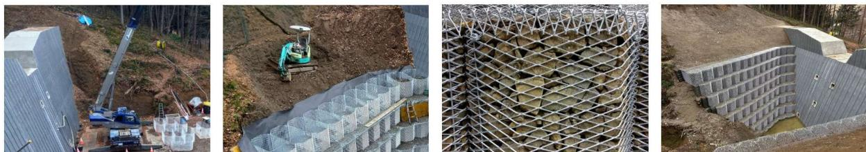
砂防堰堤上流側の護岸工兼土留工として多角形EXセルが採用された事例です。
