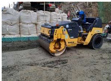
転圧・締固め状況
