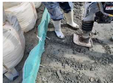
転圧・締固め状況
