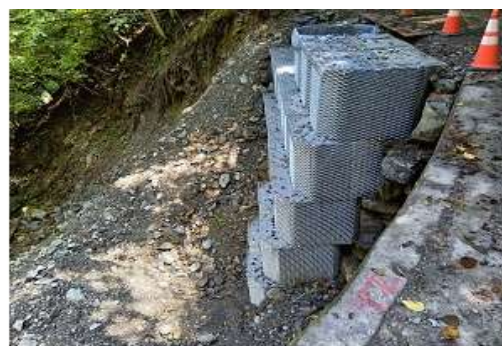
独立したセルユニットは現地形状に合わせて長さ・幅方向とも自在に連結可能です
