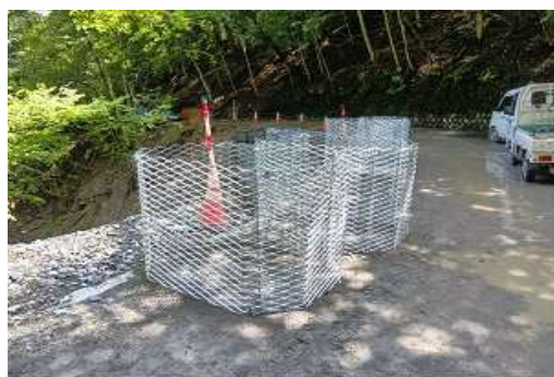
独立したセルユニットは現地形状に合わせて長さ・幅方向とも自在に連結可能です
