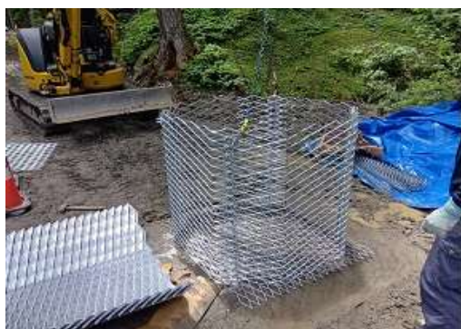
丘で組み立てたセルユニットを吊り下ろし隣り合うセル同士をコイル連結します
