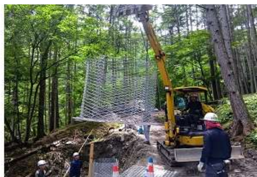
丘で組み立てたセルユニットを吊り下ろし隣り合うセル同士をコイル連結します
