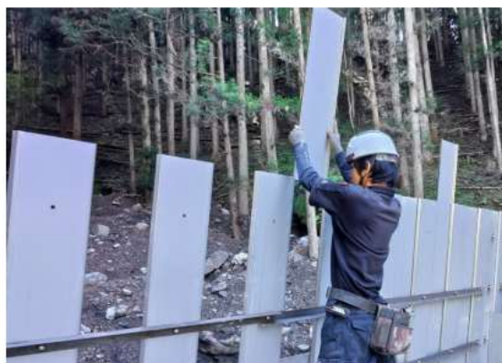
壁面パネル組立
