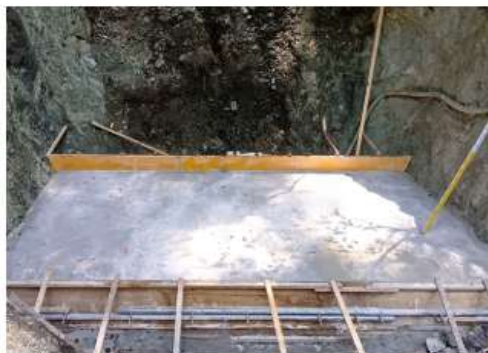
底版コンクリート（一次）打設
