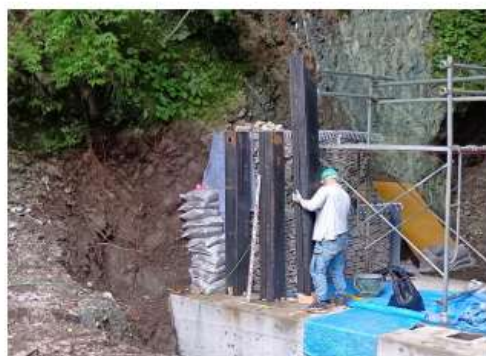
鋼管柱建込み
