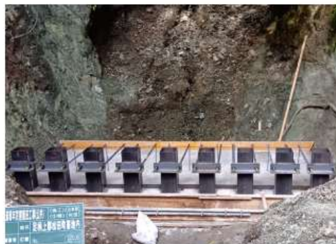
基礎鞘管設置
