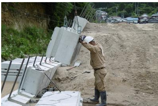
■ ブロック設置
