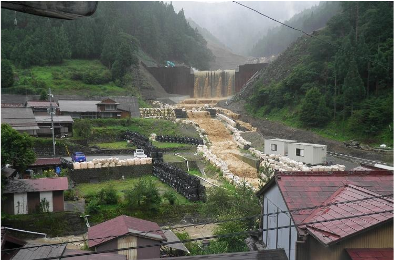
■ 台風豪雨(2014年8月)時の越流状況(北股地区) 下流域に被害なし。
