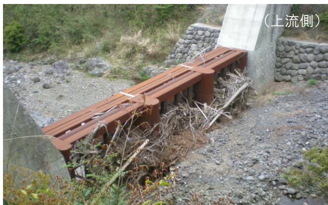
富士山千束第4砂防堰堤/国)富士砂防事務所
