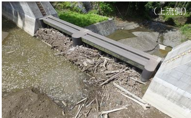
野沢川砂防堰堤/県)沼津土木事務所
