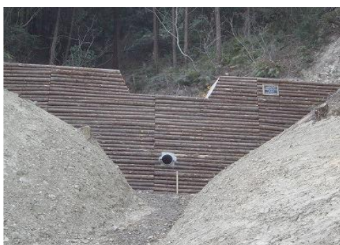
工事名:末美谷山復旧治山工事 --- 発注者:林)四国森林管理署 商 品:間伐ダブルウォール 規 模:H=5.0m、L=18.0m (2006年竣工) -----
