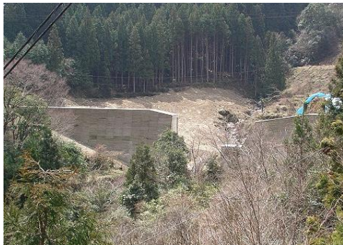
工事名:千足谷砂防堰堤 ----- 発注者:国)四国山地砂防事務所 商 品:間伐フォームレス 規 模:1,550㎡ (2005年竣工) -----
