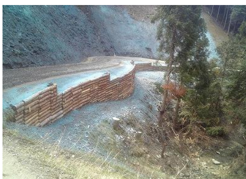
工事名:林道横谷線開設工事 ---- 発注者:愛媛県)四国中央市役所 商 品:間伐LXウォール 規 模:L=108.0m、H=3.0m (2007年竣工) -----
