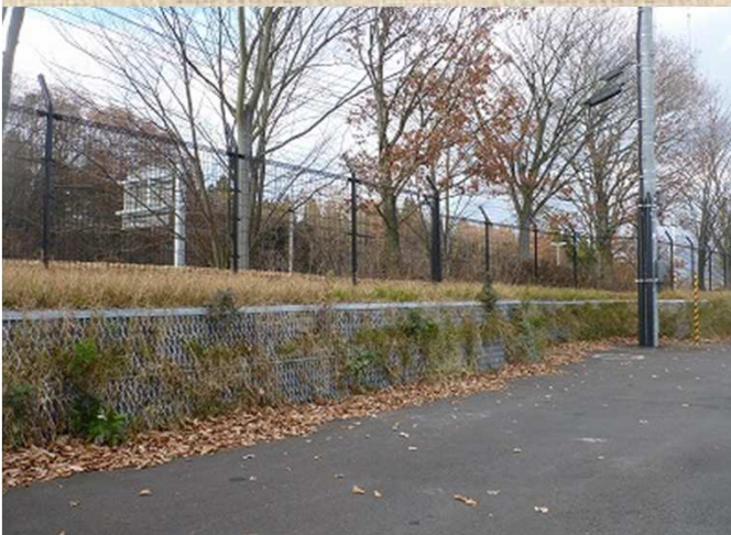
宮城県)仙台市内の駐車場 (MBLN)
