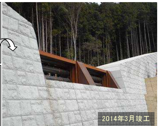
⑤中津川第10砂防堰堤 国)多治見砂防国道事務所 ■開口部高さ: 12.5m ■水通し幅 : 20.0m ■最大礫径 : 2.6m
