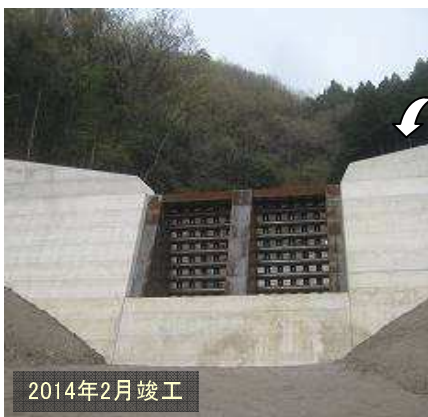
②中谷川砂防堰堤 京都府)南丹土木事務所 ■開口部高さ: 6.0m ■水通し幅 : 10.0m ■最大礫径 : 0.4m
