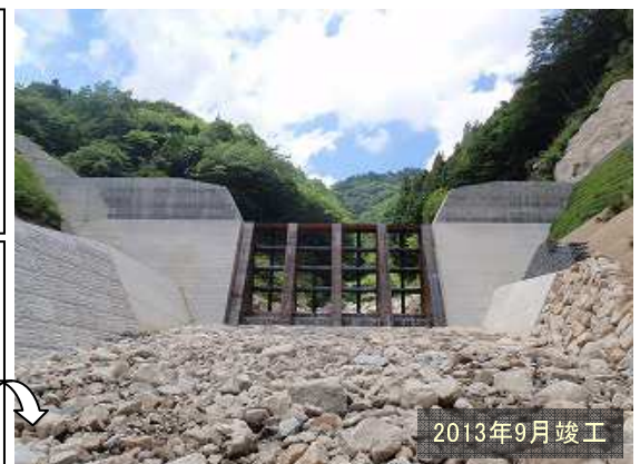
③橋ヶ谷第2砂防堰堤 国)多治見砂防国道事務所 ■開口部高さ: 9.5m ■水通し幅 : 20.0m ■最大礫径 : 1.6m
