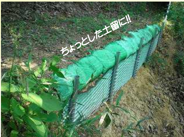
■ 岡山県久米南町役場/里道補修 ネックス柵工(NEX) : H=0.5m、L=5.0m
