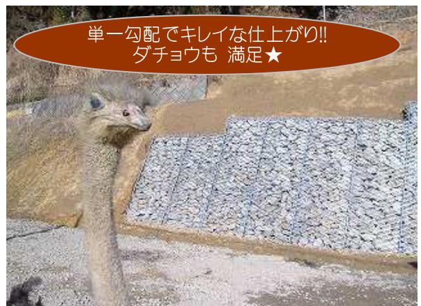
■ 山口県岩国市役所/ニツ野迫地区 ギャビオン(GBN) : Hmax=3.0m、L=8.0m
