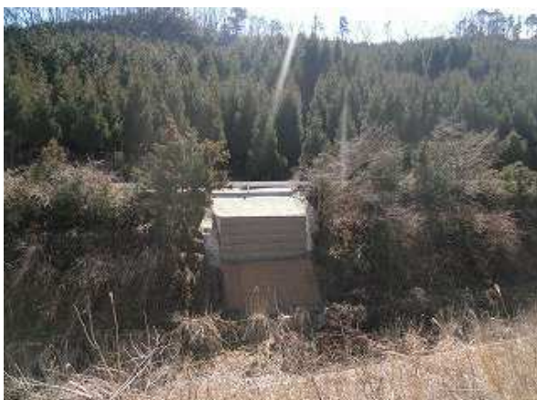
■ 鳥取県琴浦町役場/林道板倉線 ブロック工(BLN) : H=3.0m、L=6.0m
