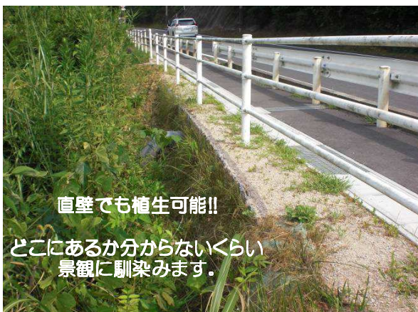
■ 広島県三次市役所/西酒屋寺町線 LXウォール(LXW) : H=1.0m、L=8.0m
