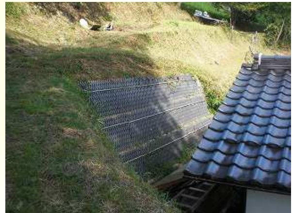
■ 岡山県美作市役所/鷺巣尾崎小災害復旧 もたれブロック工(MBLN) : H=2.4m、L=4.0m
