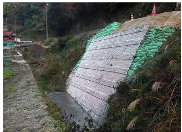
■ 山口県岩国市役所/下畑2号 もたれブロック工(MBLN) : H=4.8m、L=7.0m
