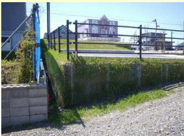
■北海道新冠町役場/本町地区公園駐車場整備 LXウォール(LXW): H=2.0m、L=15.7m(合計)
