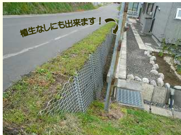
■北海道苫前町役場/古丹別南5丁目改良工事 LXウォール(LXW): Hmax=1.5m、L=8.0m
