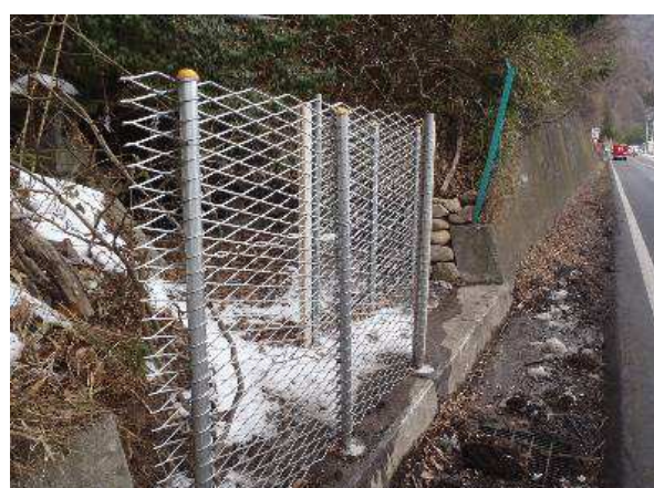
■長野県上田建設事務所/大日向 ネックス柵工(NEX): H=1.0m、L=2.0m×2列
