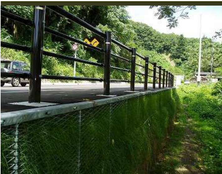
国)長岡国道事務所【一般国道8号大積千本災害復旧工事】
