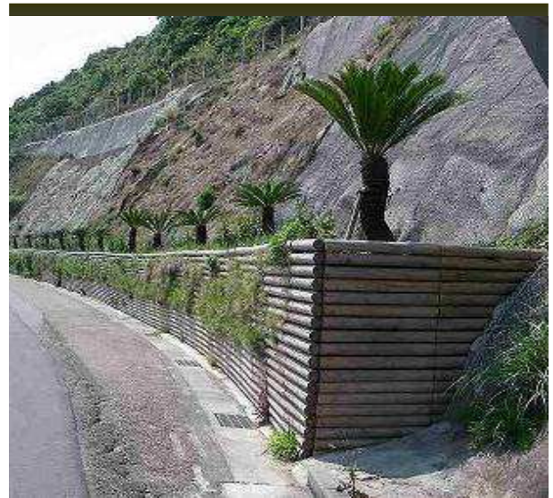
国)宮崎河川国道事務所【法面防災工事風田地区】
