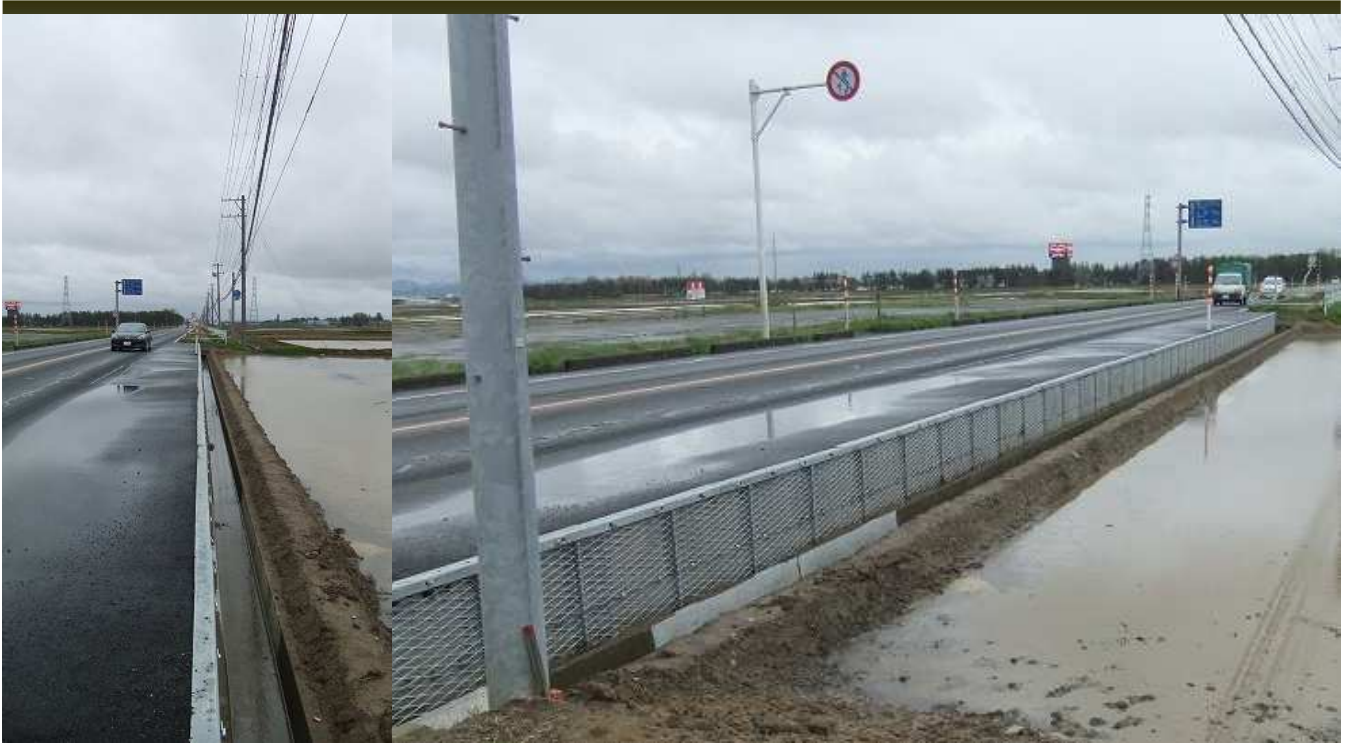
国)新潟国道事務所【吉田西太田交差点改良工事】
