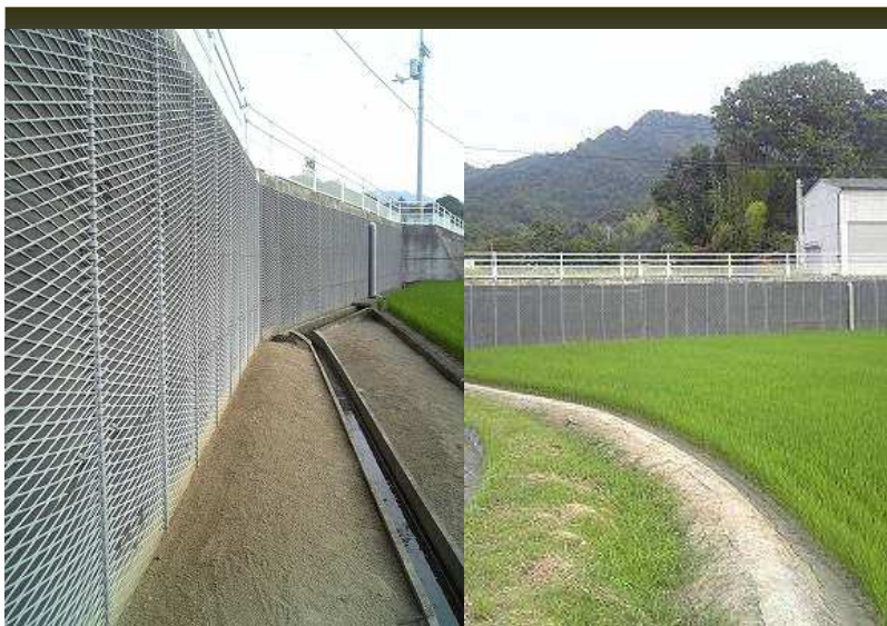
県)長尾土木事務所【国道318号線道路拡幅工事】
