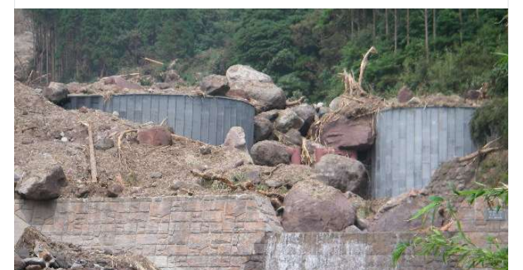
船石川第2砂防ダム／鹿児島県
