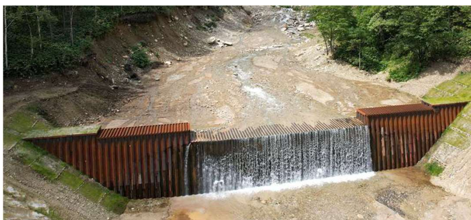
ペケレベツ川支川谷止工／十勝西部森林管理署
