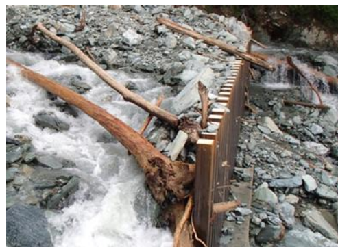
写真-4 応急対策工の事例
