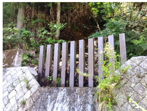
写真-3 道路防災対策工の事例
