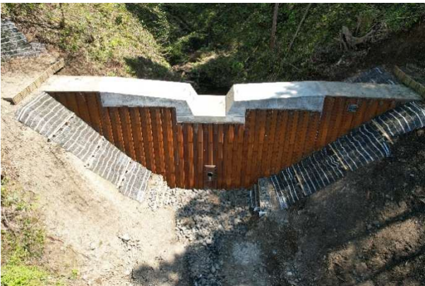
写真-1 仁別谷止工
