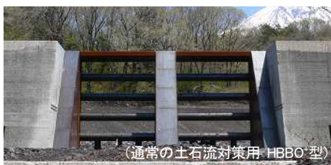
図-1 無流水溪流用バットレス型対策工の構造概要
