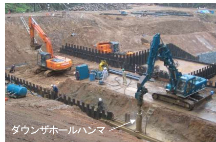
図-5 ダウンザホールハンマ施工状況
