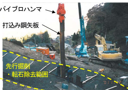
図-4 鋼矢板基礎打込み状況
