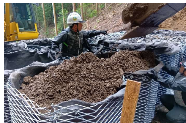
写真-5 重機による中詰材(現地発生土)の投入
