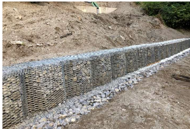
写真-2 土留め兼護岸工としての適用事例
