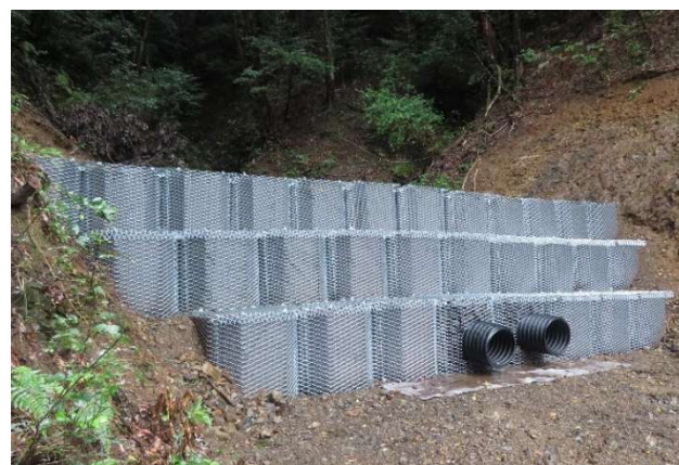
写真-4 応急対策工としての適用事例
