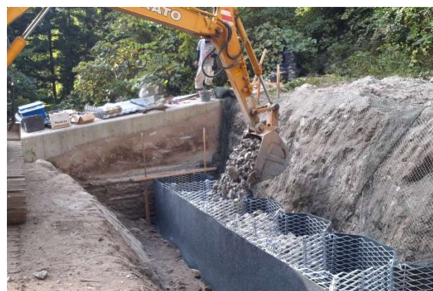
写真-3 重機による中詰材(割栗石)の投入
