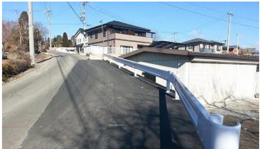
国)二戸国道管内舗装修繕工事／工法:ブロック・ノン(BLN)
