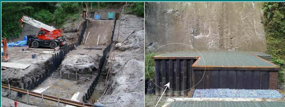
袖部貫入ゼロ工法は、地山貫入部に相当する堤体を上流方向へ設けることで十分な浸透流路長を確保
