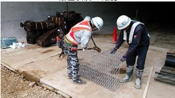
壁面材のカット
