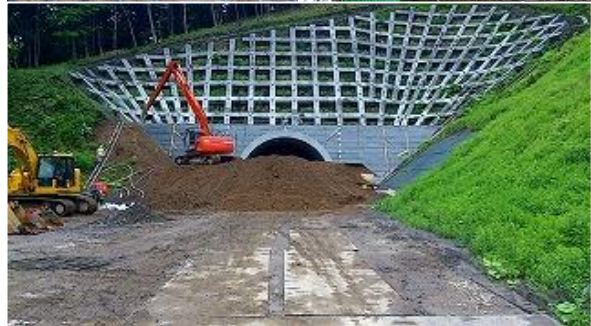
中詰材投入状況
