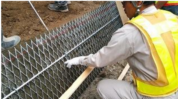
転圧状況の確認
