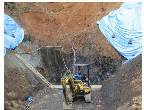
写真-1 上流側掘削法面
