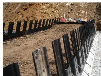
写真-4 上半部壁面材設置
