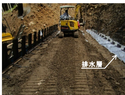
写真-3 中詰材敷均し状況
