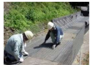
写真-3 組立の様子
