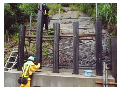
写真-4 鋼管柱の建込み状況
