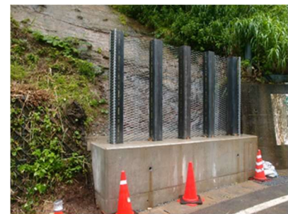
写真-3 道路保全対策の設置事例
