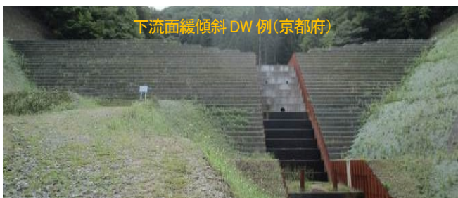
図-1 鋼矢板基礎付き DW 堰堤および下流面緩傾斜 DW
